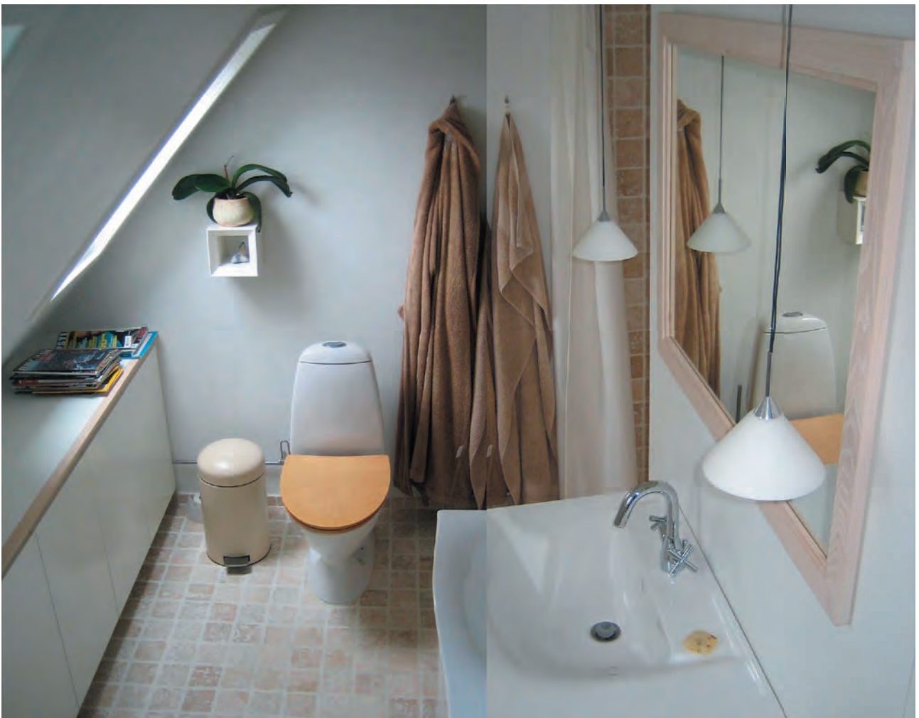
Grundtype B - eksempel fra Markvej 30 på udvidelse og ombygning af badeværelse. Det gamle pulterrum er inddraget, og det oprindelige wc-rum er udnyttet til bruseniche. Se plan i 1:100 på næste side.
